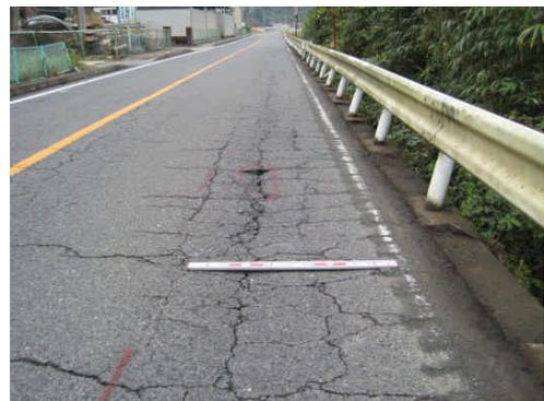
写真 - 4 施工前の路面状況 (事例 A)
